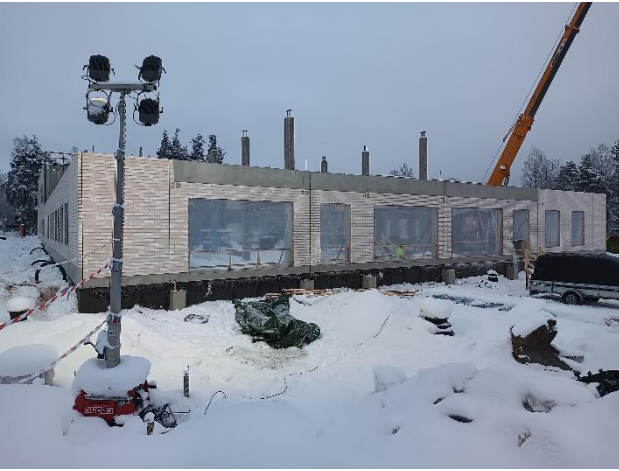
1.krs, lohkon 3 seinäasennukset. Teräspalkit ja ontelolaatat seuraavat perästä.
