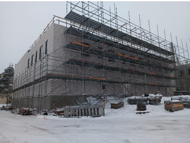
Sääsuojatelineiden asennukset, kaakkoiskulmalta (uimahallin puoli).
