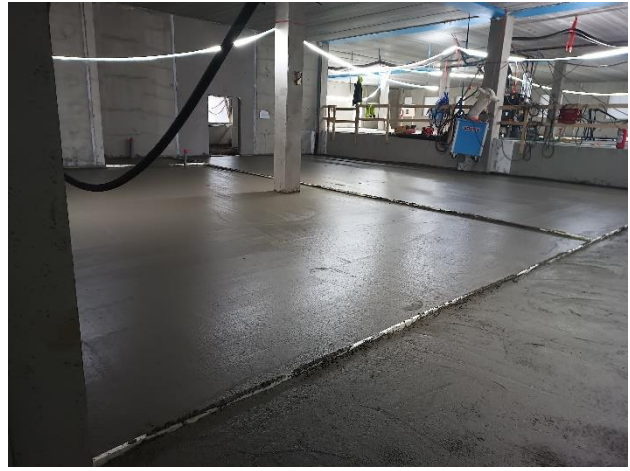
1.krs, lohkon 2 lattiavalut. Ylemmän osan lattia valettu viime viikolla.
